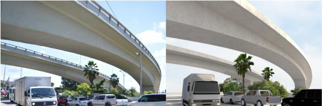
(a) Vista lateral do vão principal ressaltando a variação da altura da seção transversal sobre as vias de circulação inferior, permitindo também visualizar parte da curvatura horizontal ao longo do desenvolvimento do viaduto.
