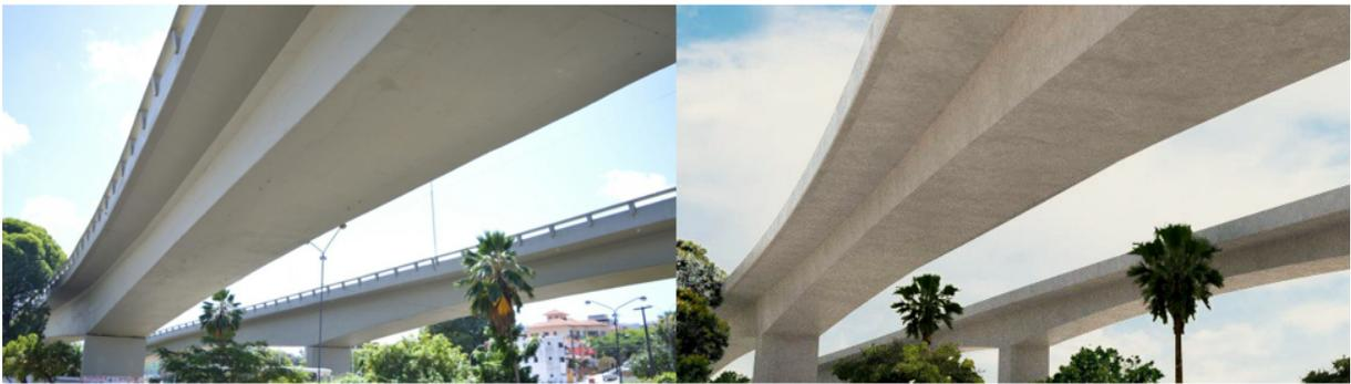
(b) Vista inferior do vão principal onde pode ser observada a manutenção das proporções entre os elementos da seção transversal, além da confirmação da variação da altura da seção pela estrutura mais afastada.
